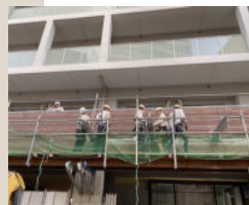
♪玄関前庇を建てている時の様子。庇が傾かないよう、数人がかりでミリ単位の調整を行います。
