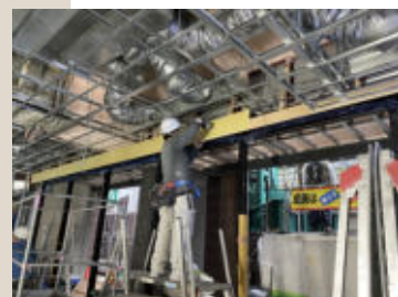
♪玄関前庇を建てている時の様子。庇が傾かないよう、数人がかりでミリ単位の調整を行います。
