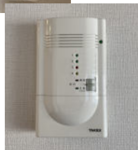
♪センサーと連動している報知器。4段階で職員に発報します。
