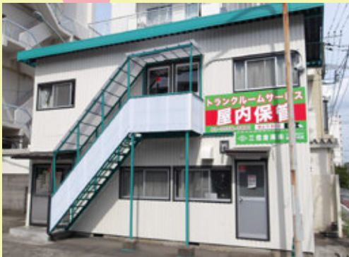
◀作業中の床が抜けたり、工事中にトラブルもたくさんありましたが、無事に工事が完了しました！
