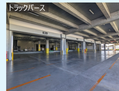
トラックバース 自走式ランプウェイでトラックやトレーラーがそのまま倉庫荷捌場の前まで入ってくるができます。
